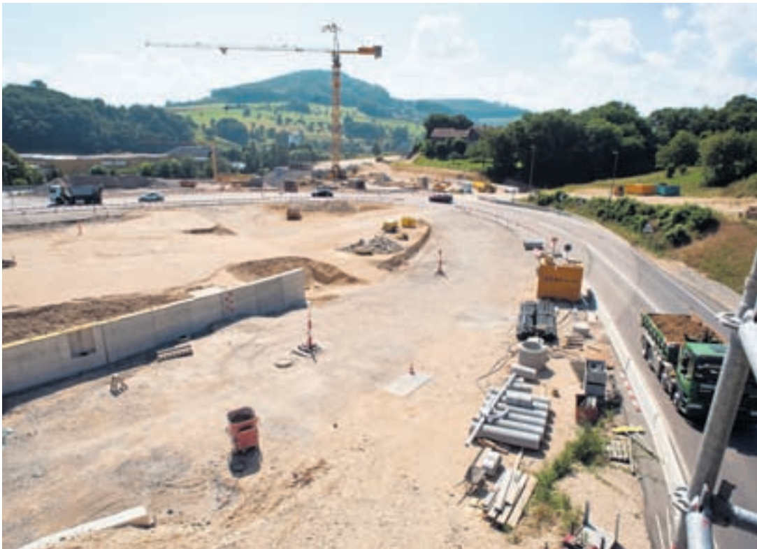
Grossbaustelle. In der Hülften entsteht ein Kreis mit 66 Metern Durchmesser, der grösste im Baselbiet (links); rechts die Stützwände für den Tunnelbau unterhalb der Rheinstrasse in Füllinsdorf. Fotos Roland Schmid
