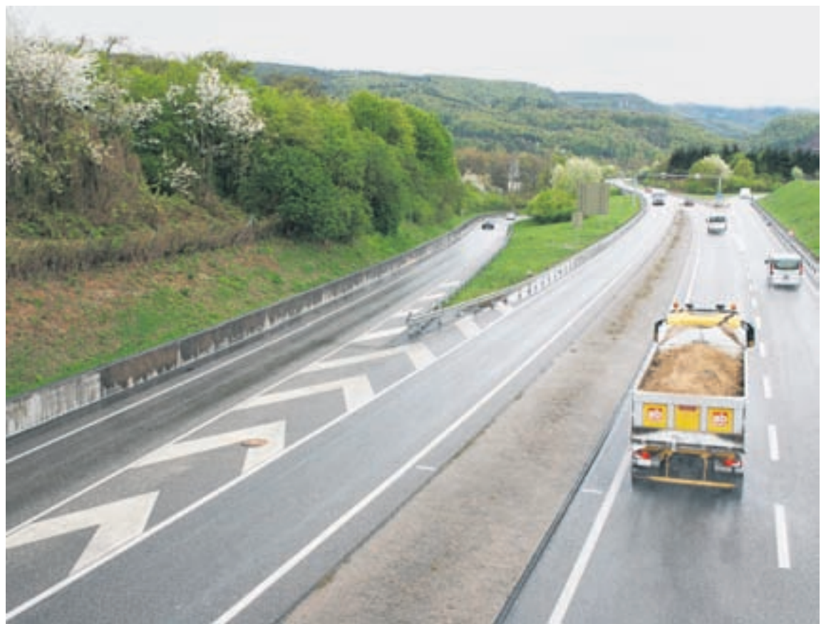
H18. Vor zehn Jahren forderten drei Kantone die Aufnahme ins Nationalstrassennetz. Foto Henry Muchenberger
